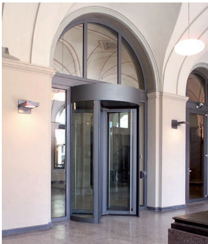
Гибкая интеграция: карусельная дверь безопасности в историческом здании.
