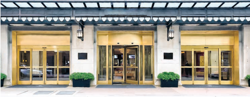
Crane BZ3000-A (Entrée complète) Architecte : Lucien Lagrange & Associates
