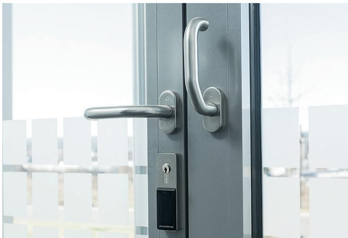
Versione con elettronica integrata: il modulo elettronico nel lato interno della porta.
