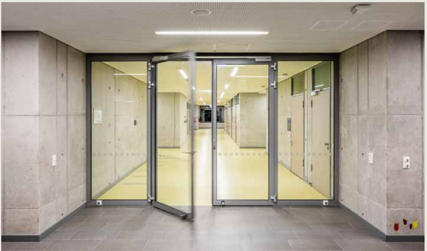
TS 98 XEA GSR EMR dørholdsystem med ekstern EM 500 dørholdmagneter.
