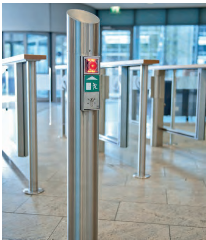
Стойка и картоприемник с терминалом эвакуационного выхода
