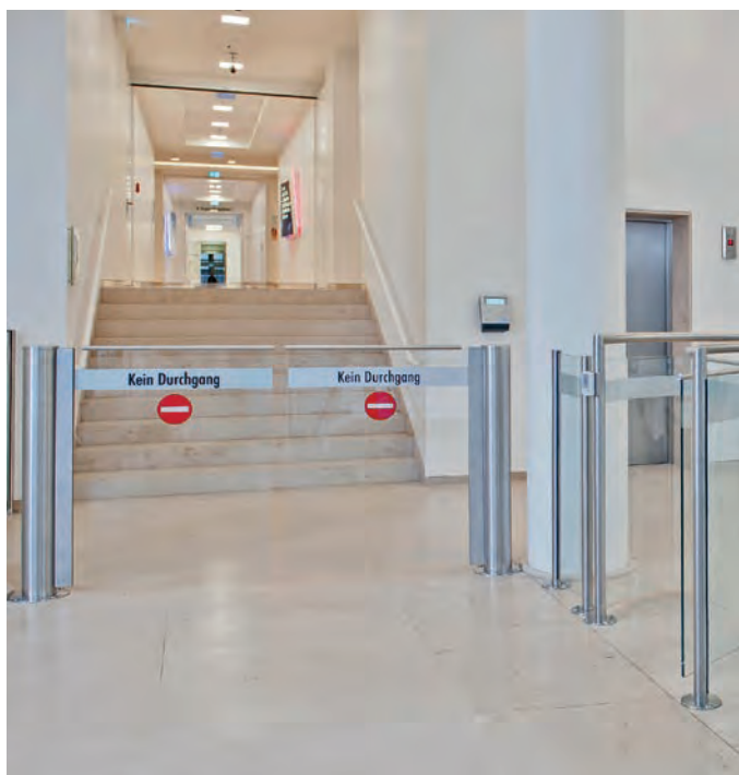
Высота стойки и створки калитки по верхнему краю составляет 1200 мм
